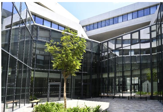
Cours intérieure du bâtiment ©Agglomération Cannes Lérins
