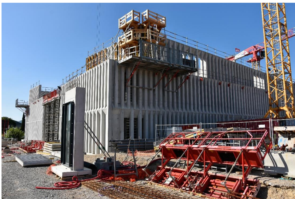
Travaux du Campus Georges Méliès ©Agglomération Cannes
